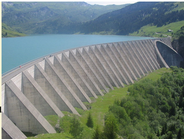
Barrage hydroélectrique de Roselend
